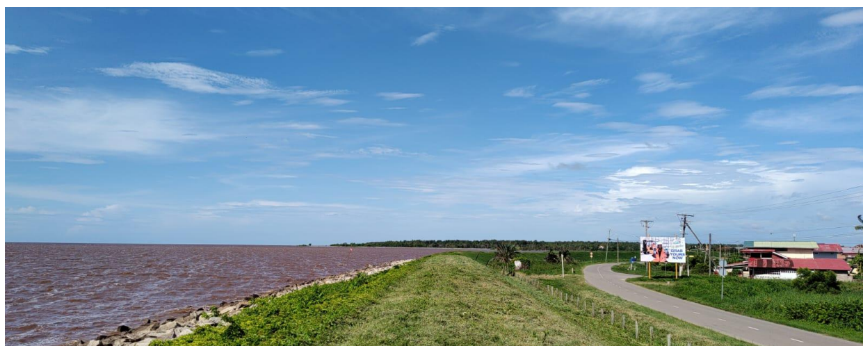
Figura 21 - Dique em Nieuw Nickerie.
