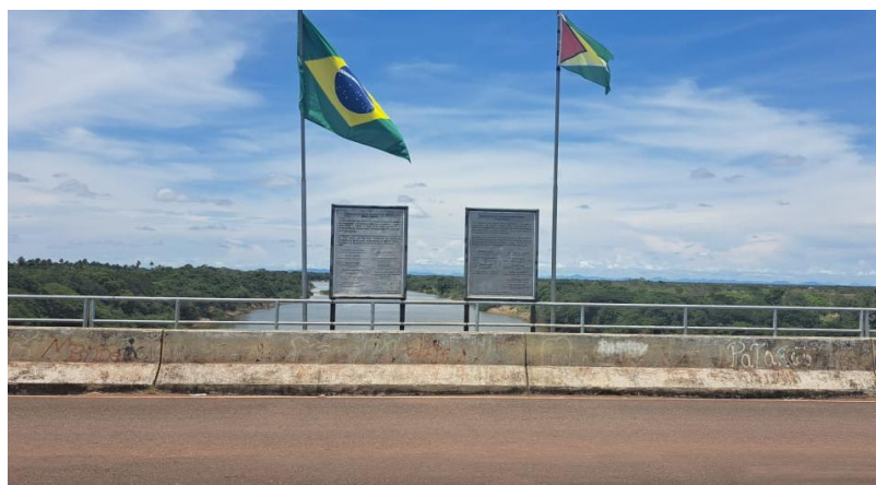
Figura 24 - Ponte sobre o rio Takutu.
