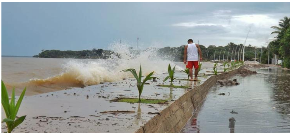
Figura 5: Alagamento ocorrido na praia do Marahu em fevereiro de 2019.
