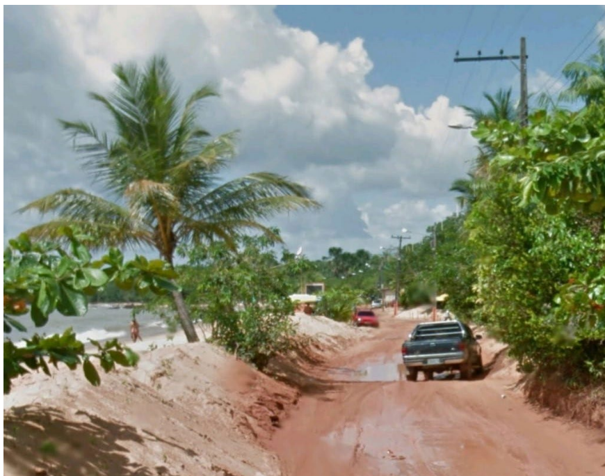
Figura 6: Solo compactado pela circulação de veículos
