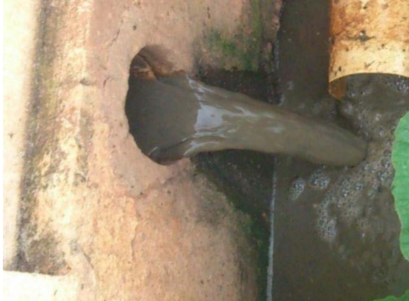
Figura 3. Efluente bruto na saída das instalações. Marabá-PA.
