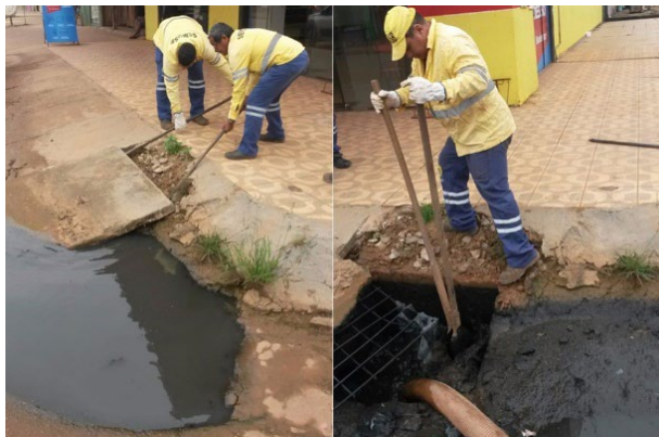
Figura 09. Servidores desobstruindo um bueiro.
