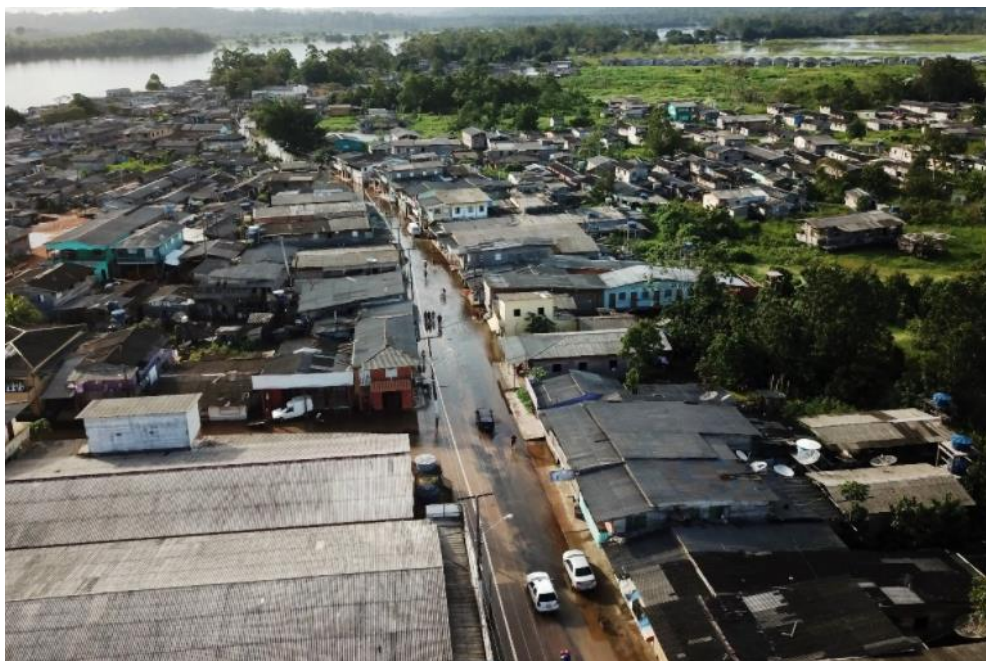
Figura 5 – Aspecto da inundação da sede urbana de Laranjal do Jari, Av. Tancredo Neves, ocorrida em 2018
