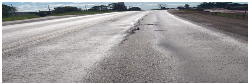
Figura 11 – Afundamento plástico seguido de uma ondulação.
