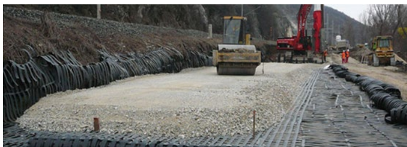
Figura 2 – Execução de camada de brita sobre base impermeabilizada.
