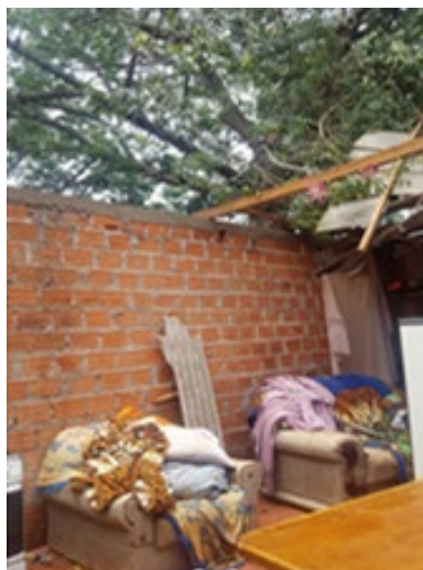
Figura 7. Destelhamento
