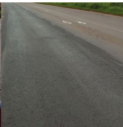
Figura 4 – Pavimento após a recuperação.
