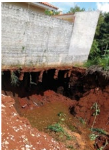
Figura 6. Aterro em cima da rede de galerias pluviais
