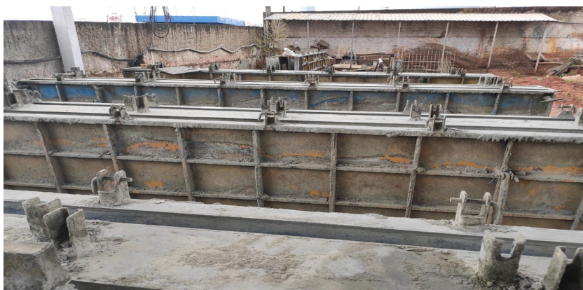
Figura 4 – Montagem das placas pré-moldadas realizadas fora do canteiro de obra.
